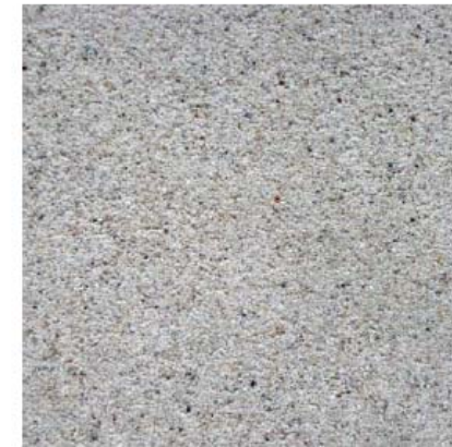
Béton désactivé fin
