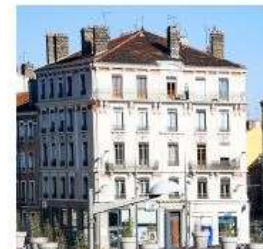
façade du bâtiment.
